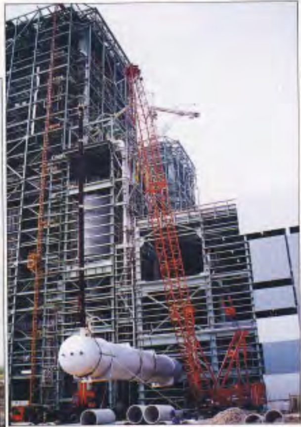
• 하동 화력발전소 120톤 탱크설치
